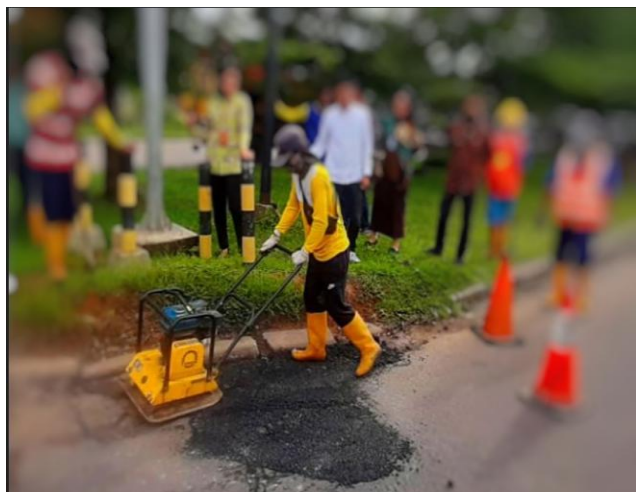
Gambar 4 Pekerjaan Campuran Aspal Panas
