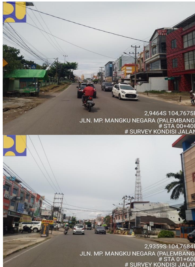
Gambar 2 Foto Kondisi Jalan dalam Pelaksanaan Survei Kondisi Jalan
