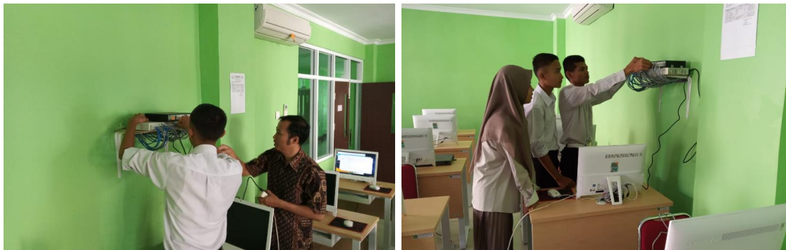
Gambar 3. Dokumentasi proses praktikum instalasi jaringan komputer
